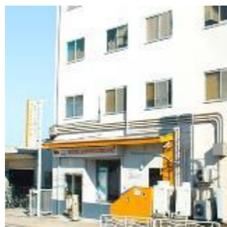
東京リユースセンター 開設：2010年
